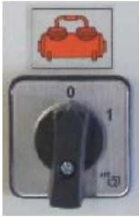
Figura 20: Seletor do compressor de ar
