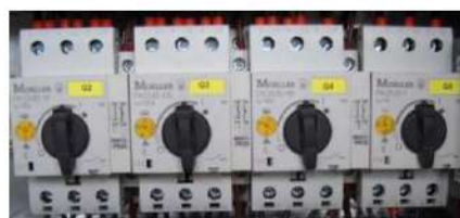
Figura 5: Interruptor de proteção do motor
